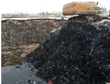
図9 処分場の掘り起こし作業
