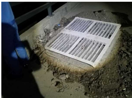
図 11 ステンレス鋼材製の排水スクリーン
